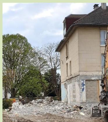
Une fois l'aile sud écroulée, la pelleteuse et les camions ont déblayé les gravats pour laisser place à la future étape du chantier : la construction d'une nouvelle extension qui sera sur 4 niveaux.
