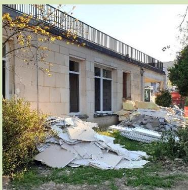
Tout d'abord les ouvriers ont démonté délicatement des éléments du bâtiment pour pouvoir trier et recycler les différents matériaux.
