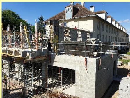
Le gros œuvre du rez-de-chaussée est terminé et l'élévation du 1<sup>er</sup> étage est en cours.
